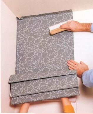
Приложите верхнюю часть полосы к стене, оставив нижнюю половину сложенной. Выровняйте край полосы по начерченной линии, оставив сверху стены запас 3-5 см.
